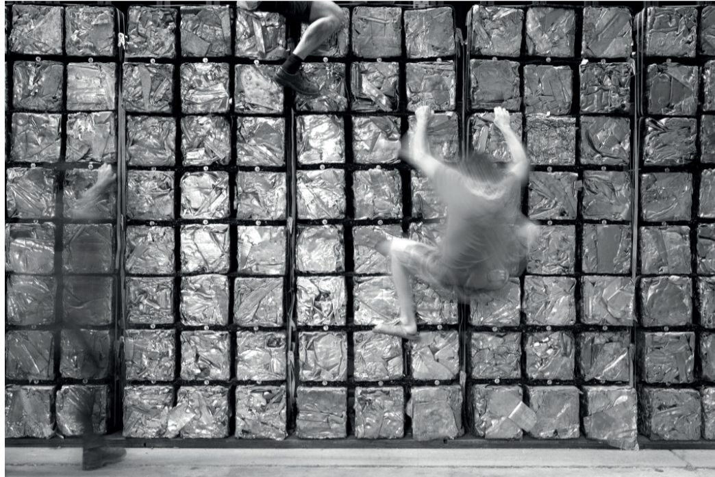
temporäre Wand aus gepressten Aluminium-Blöcken, Wagenhallen/ Stuttgart 2012, Büro Umschichten, Foto by Umschichten
